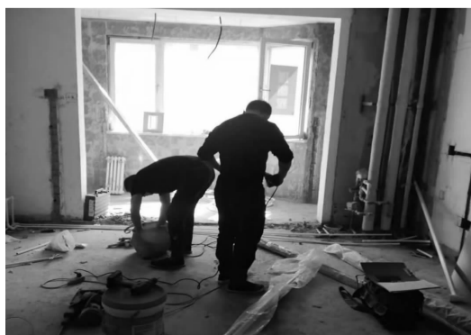
金港国际居民家中施工现场
